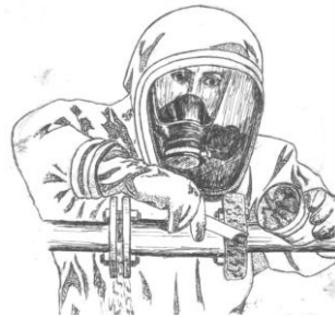
Рис. 3. Герметизація фланцевих з'єднань
