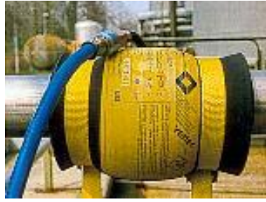
Рис. 2. Герметизація трубопроводів
