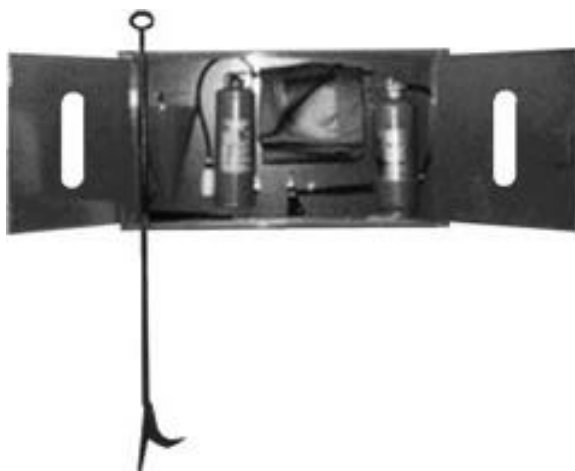
Рисунок 15.2 – Пожежний щит закритого типу
